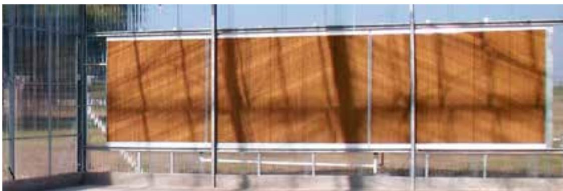
**Figura 2** Sistema de paneles húmedos. Tomado de <https://www.adcinvernaderos.com.ar/invernaderos-automatizacion.php>
