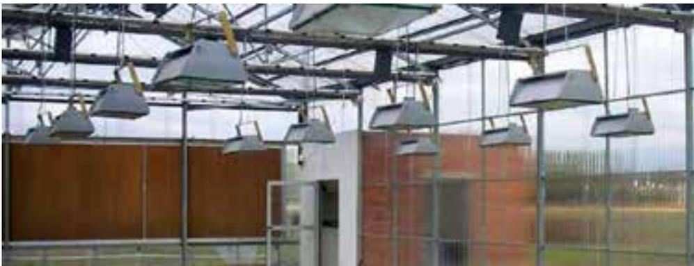
**Figura 1** Vivero tipo con cobertura de chapa "cristal" y suplemento de luz artificial. Tomado de <https://www.adcinvernaderos.com.ar/invernaderos-automatizacion.php>
